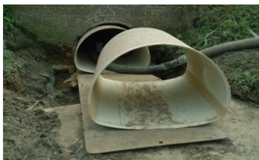
Figure 1 : Principe de réhabilitation par coque entière mono-élément.
