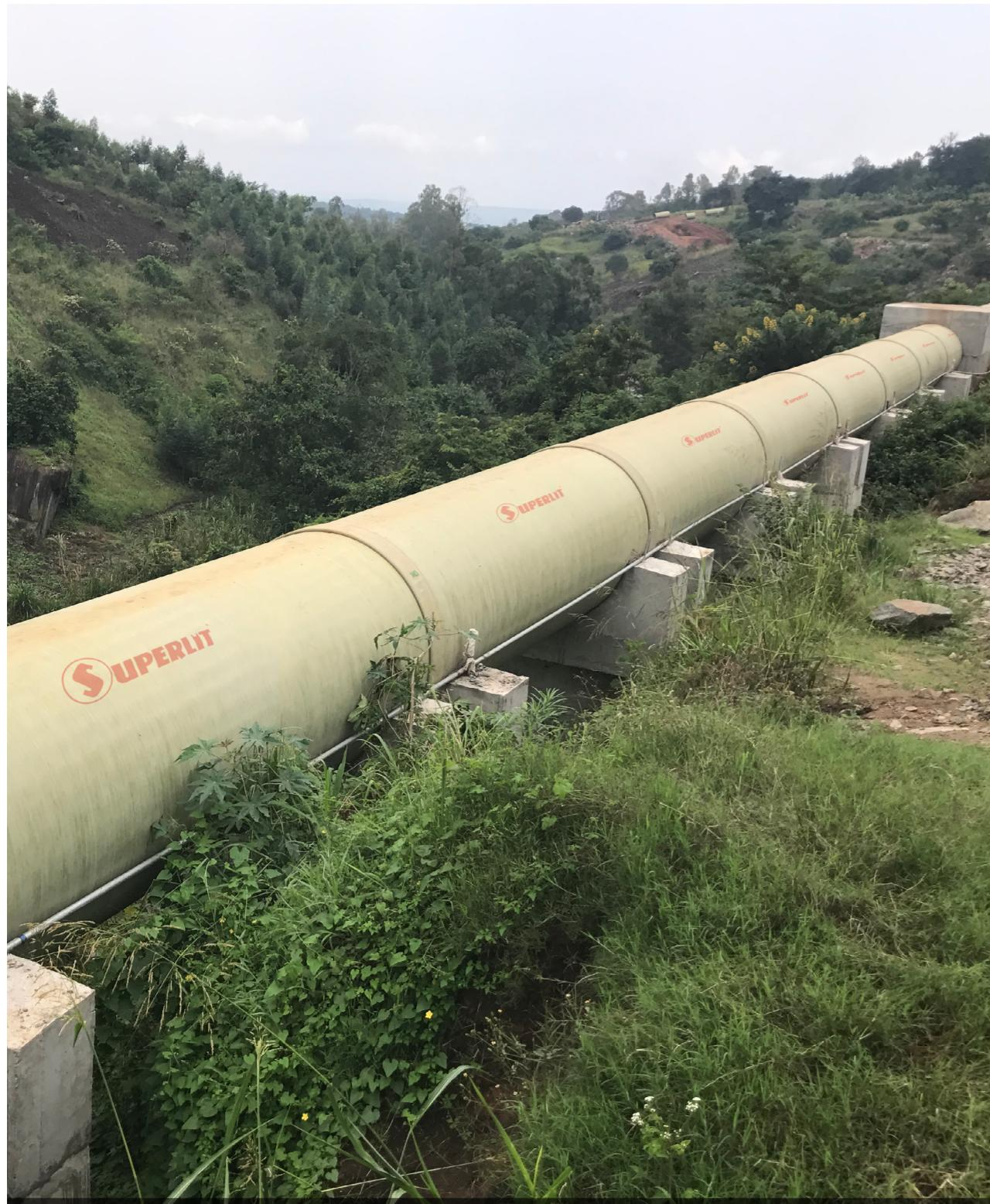
**Conduites de transport et conduites forcées des centrales hydroélectriques**
